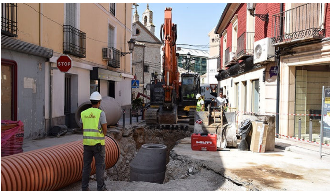
Las obras de mejora de la red de saneamiento en la calle Zapatería de Tarancón entran en su recta final 2
