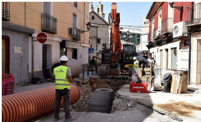
Las obras en la red de saneamiento concluyen en el tramo de la calle Zapatería y avanzan hacia la glorieta del Convento. / AYTO
