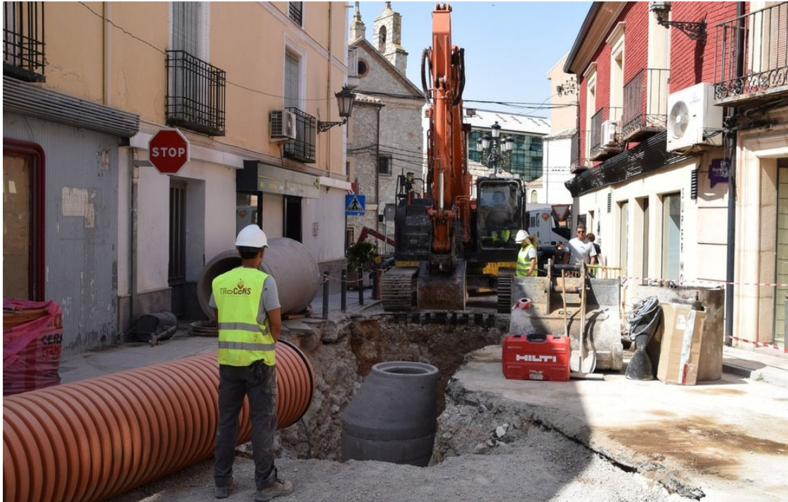
Las mejoras en la red de saneamiento de la calle Zapatería, cerca de finalizar - Foto: Ayuntamiento
